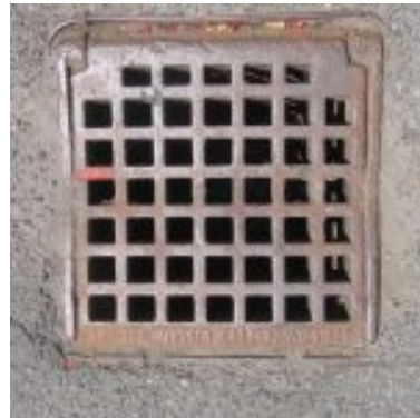
Kanaldeckel 1907 Waagner AG, 1905
